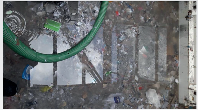
Der Blick in den Betonschacht unter dem UFS
