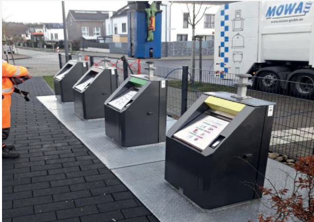
UFS werden in die geschlossene Waschkammer gehoben
